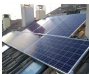
Seis módulos coplanares de 270 Wp, tres de ellos en vertical en la parte superior del agua sur del tejado, y debajo los otros tres módulos en horizontal, con tres microinversores de 500 W instalados debajo de los módulos y sobre los viales de estructura de aluminio.
